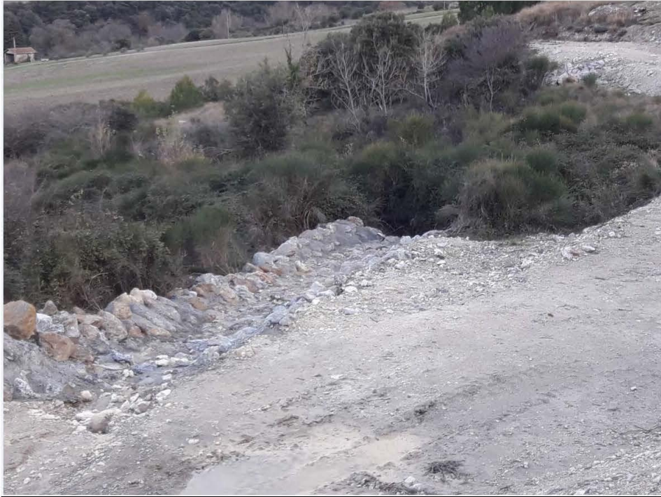
Point d'observation 9 : Zone aval aménagée avec enrochements bétonnés
