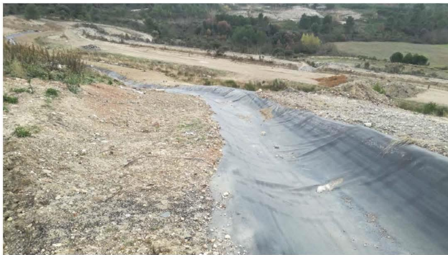
Zone 7.2 : Fossé étanché par géomembrane bitumineuse
