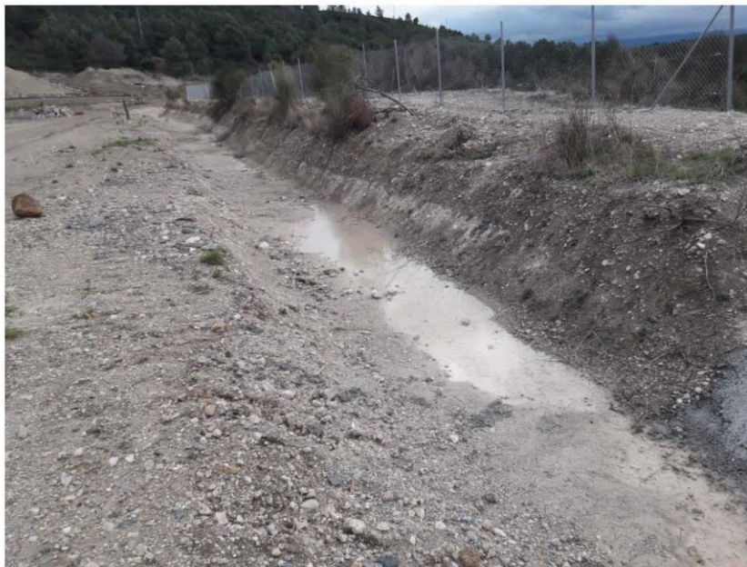
Point d'observation 8 vers le Sud /Ouest : fossé reprofilé et recalibré
