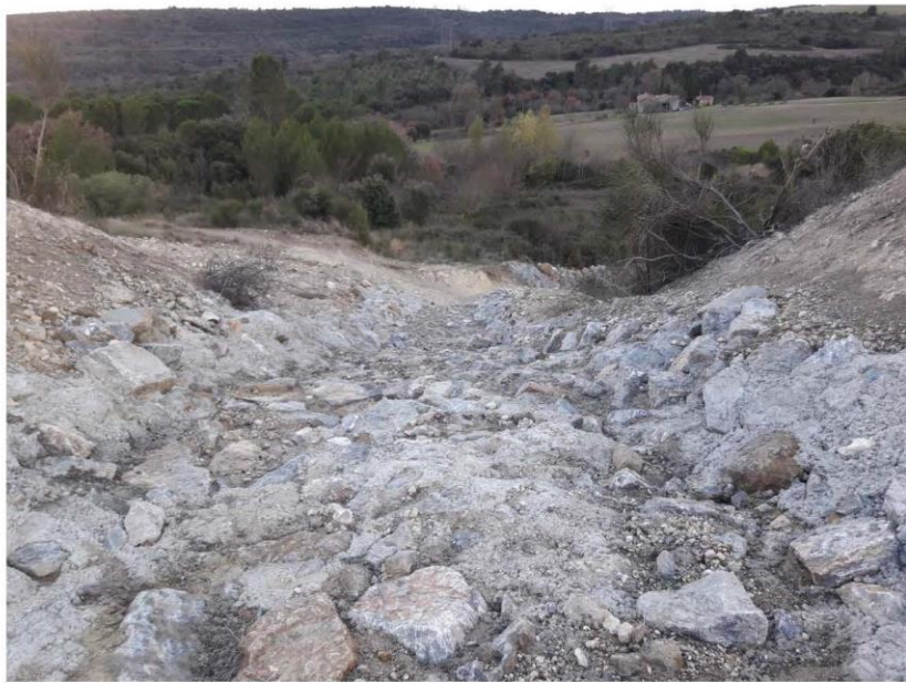
Point d'observation 8b : exutoires avec enrochements bétonnés
