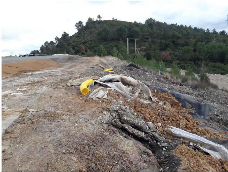
Zone 7 : Vue d'ensemble depuis le Nord-Ouest de la zone 7 en cours de travaux
