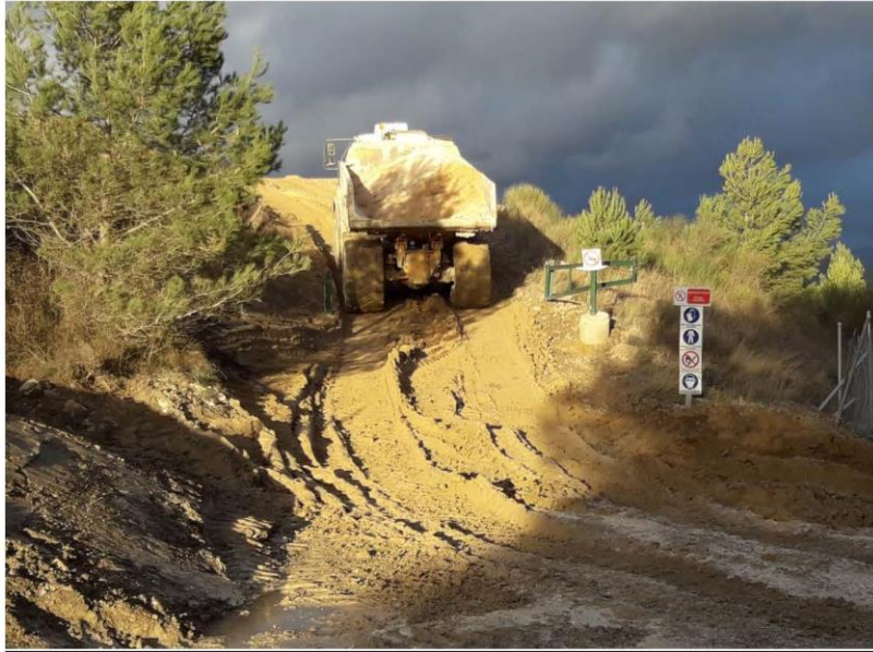
Point d'observation 1: stockage provisoire de matériaux sur ancienne zone glissée et reprise
