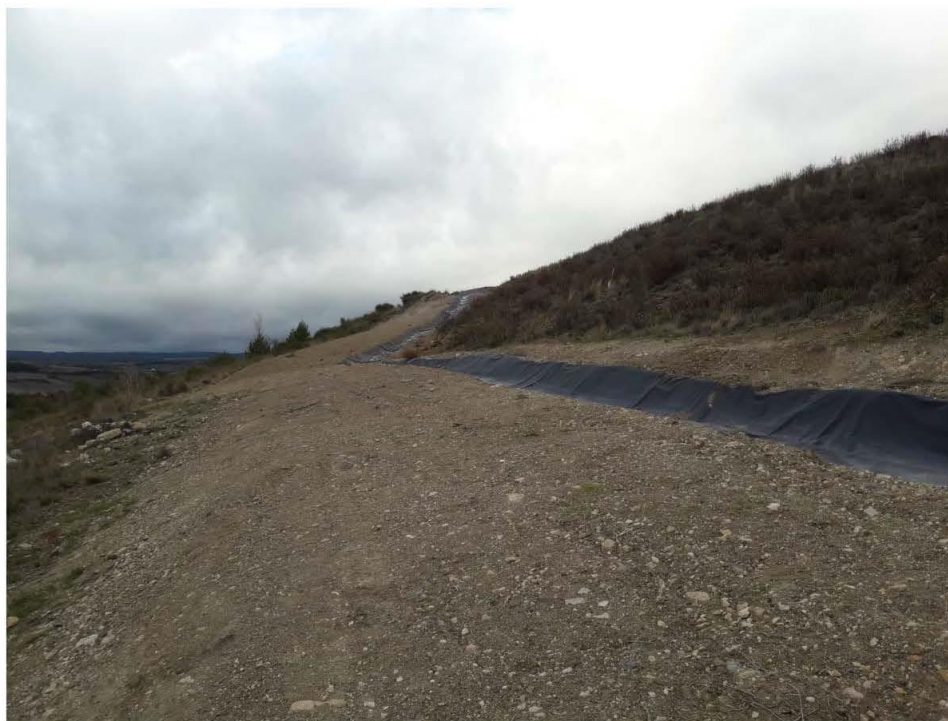
Zone 7.2 : Fossé étanché par géomembrane bitumineuse
