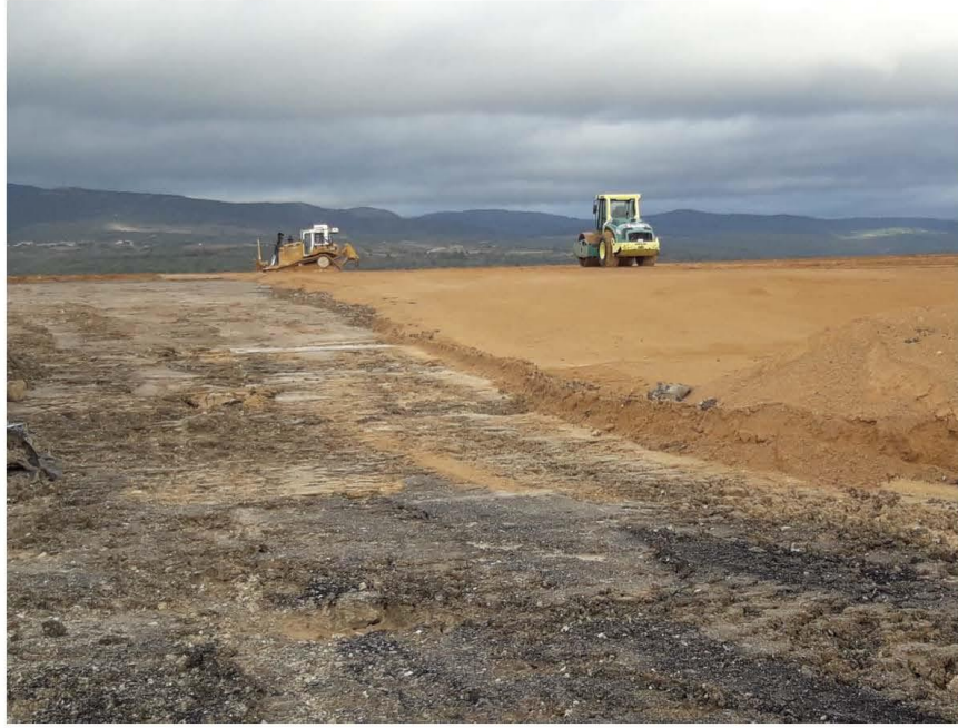
Point d'observation 2 : Toit en cours de travaux
