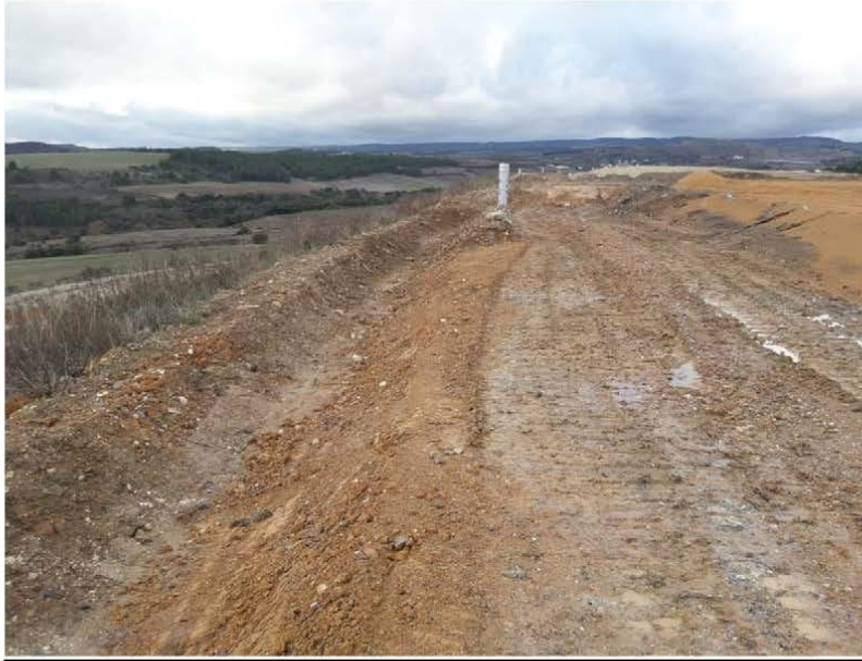
Zone 7 : Vue d'ensemble depuis le Sud-Est de la zone 7 en cours de travaux
