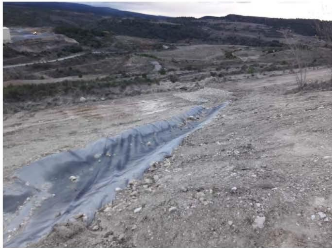
Point d'observation 11 : zone de suintement sans signe d'instabilité observée depuis 2011 terrassée avec pose d'une géomembrane
