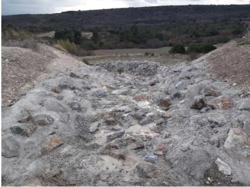
Point d'observation 8a : exutoires avec enrochements bétonnés
