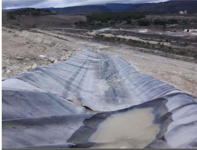
Point d'observation 11 : zone de suintement sans signe d'instabilité observée depuis 2011 terrassée avec pose d'une géomembrane
